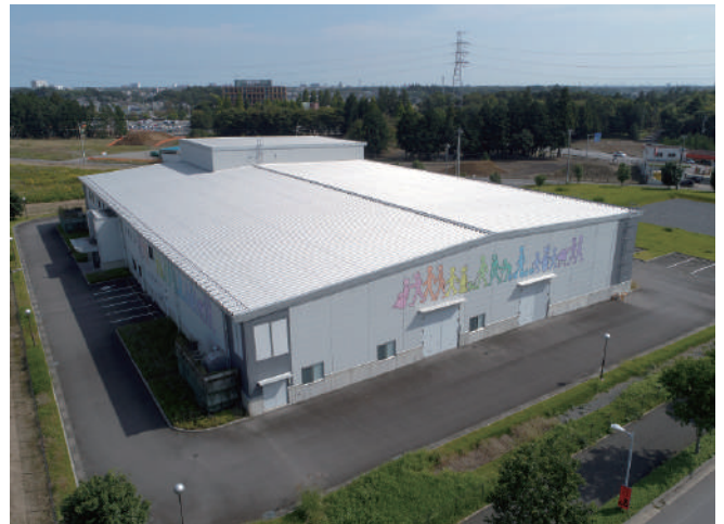
ロボット安全試験センター Robot Safety Testing Center
