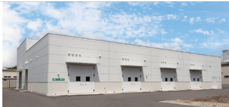
電動システム研究棟 Power Systems Research Building
