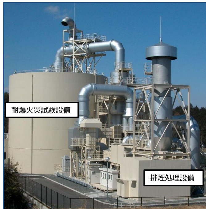
耐爆火災試験設備と排煙処理設備の外観
