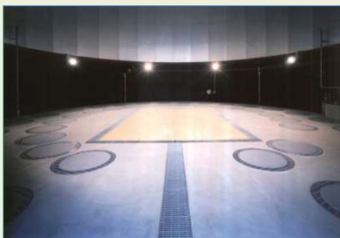
耐爆火災試験設備
