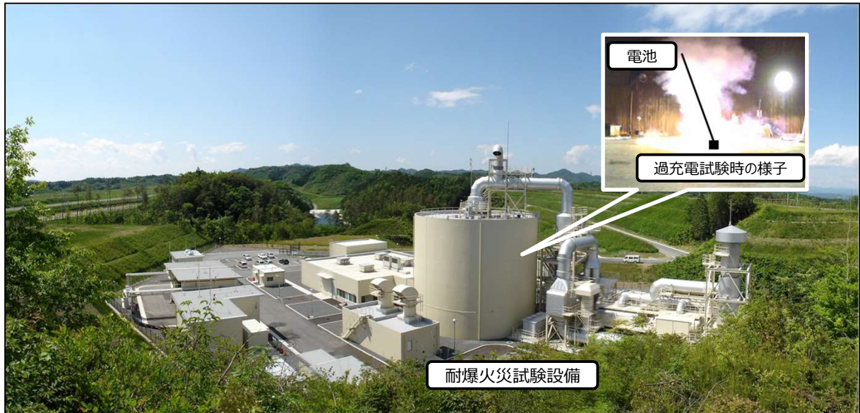
耐爆火災試験設備
