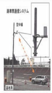
道路に設置された無線設備(基地局及び空中線)と車 両に搭載された車載器により構成され、基地局と車載 器の間を双方向に無線通信を行う。無線信号の届く 範囲は30m程度に限られており、その区域内で、情報 を順時にやりとりする。路車間通信は、被域通信 (DSRG:Dedicated Short Range Gommunication)と 呼ばれる。
