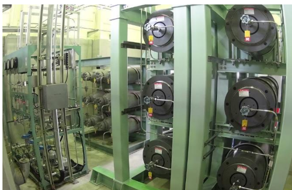
図 26 圧縮水素試験設備の蓄圧容器
