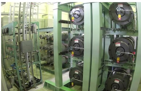
図 26 圧縮水素試験設備の蓄圧容器
