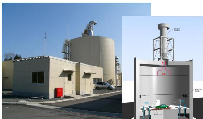
図 24 耐爆火災試験設備
