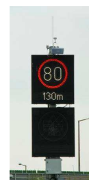
図表 7-10 標識に設置の路側機
