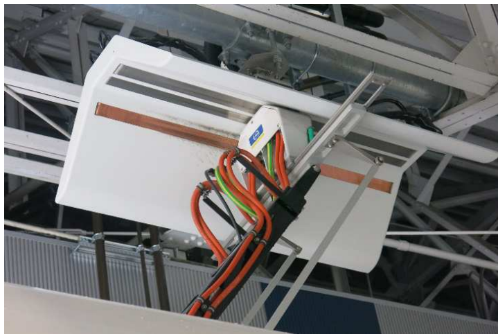
図3 パンタグラフ式急速充電器
