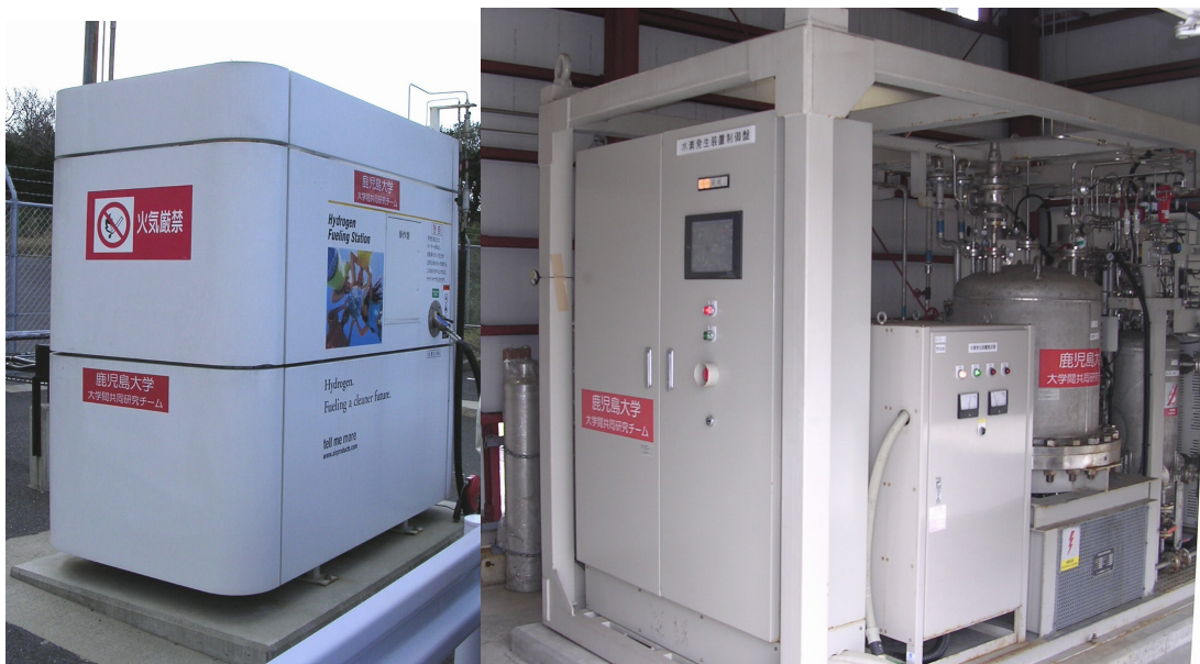
図－ 3 鹿児島大学の水素ディスペンサ(左)と水素製造装置(右)
