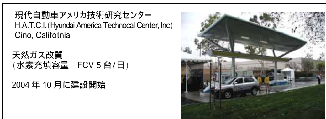
図 8-6 . 現代自動車アメリカ技術研究センターの水素ステーション 出所 : California Hydrogen Highway < http://hydrogenhighway.ca.gov/ >
