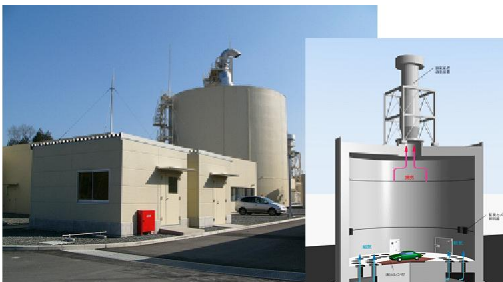
図 26 耐爆火災試験設備
