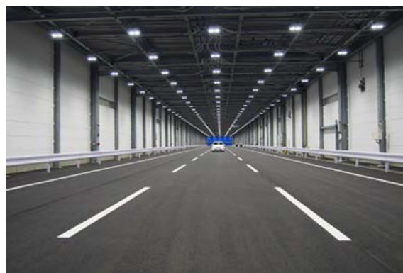
図 46 特異環境試験場 建屋内
