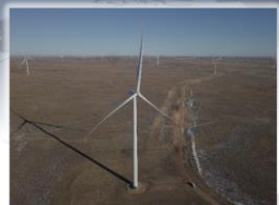
米国オクラホマ州ボイリング・スプリングス 120メガワットの風力発電所
